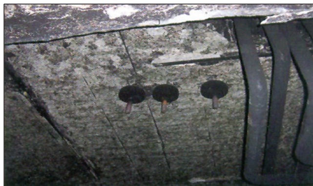
شکل ۱۳ (ج): اثر حرارت در بتون میز توربین
