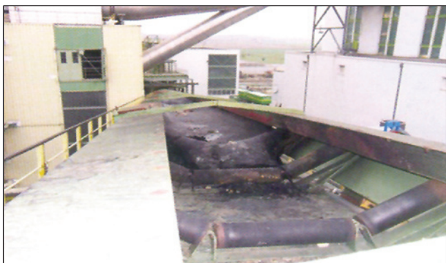
شکل ۱۳ (د): نوار حمل خلال روی سالن توربین
