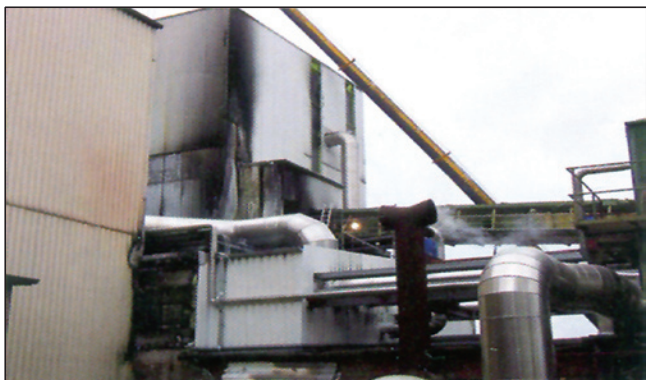
شکل ۱۳ (ب): نمای بیرونی ساختمان بونکر چغندر
